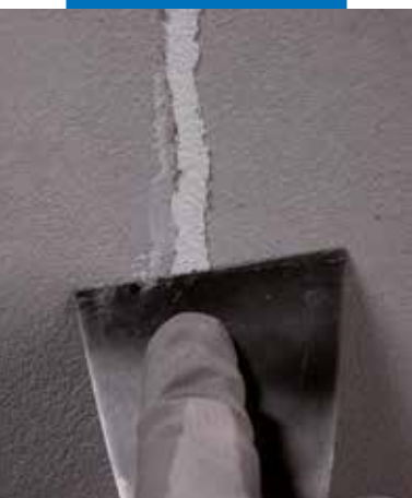
Lisciatura superficiale con spatola
