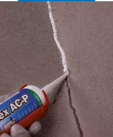
Estrusione di Mapeflex AC-P nel giunto
